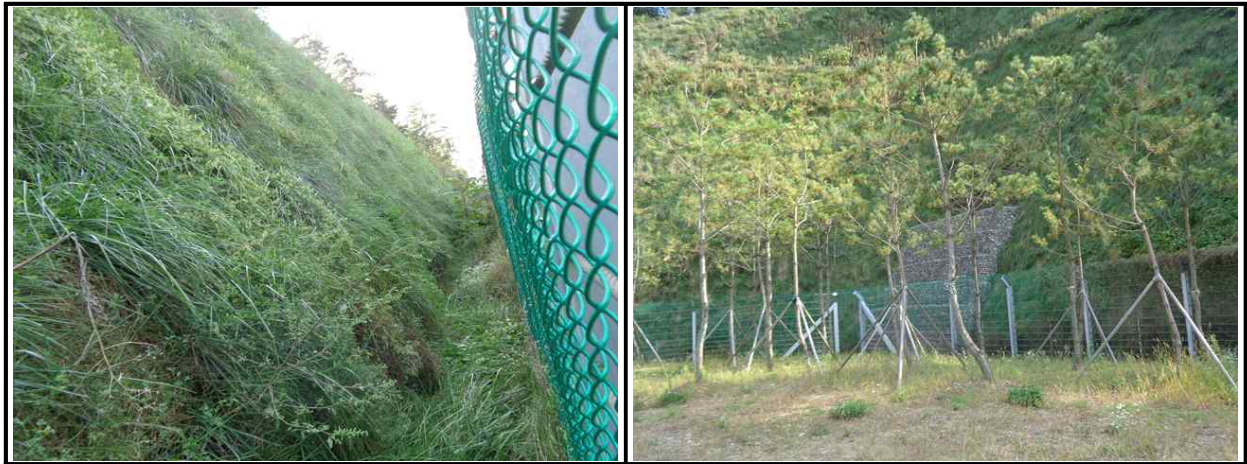
【그림 41.3.4】 보호/보강시설 전경
