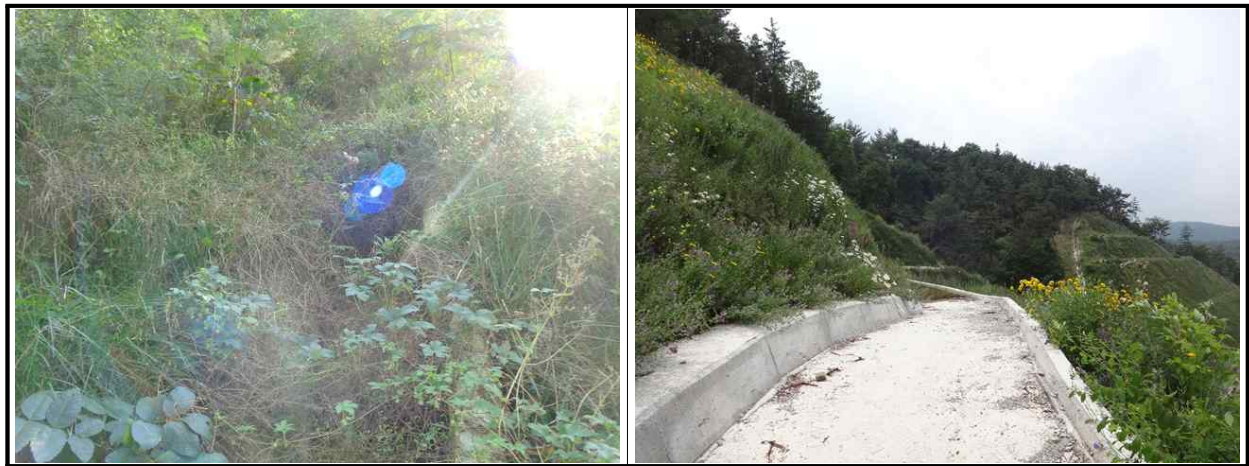
【그림 41.3.3】 배수시설 전경
